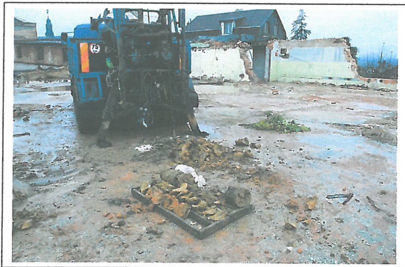
Foto 15 Vrt V-HG2 byl situován na západní straně staveniště do blízkosti IG vrtu V3, ve kterém v hloubce 3,5 – 4,5 m byla zjištěna vrstva písku. Předpokladem byla možnost, že voda bude vsakovat do této písčité vrstvy. Vrt V-HG2 byl proto hlouben do 3,7 m.
